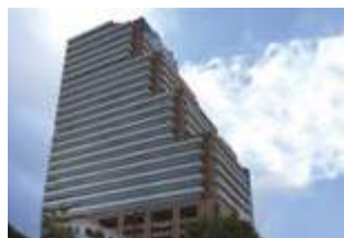
Fujitsu General (Tajlandia) Co.,Ltd. Bangkok Office (Tajlandia)
